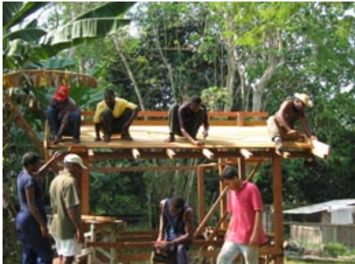
Construção de um novo galinheiro junto ao grupo vindo do Haiti.
